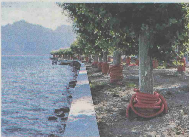
La berge a été protégée par des enrochements.
